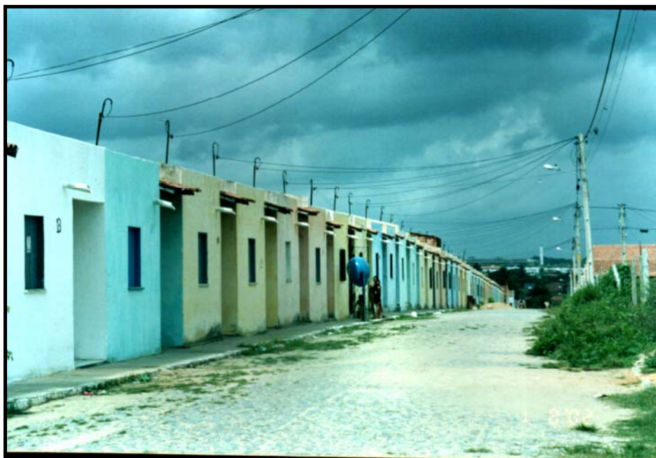
Figura 12: Conjunto Habitacional Terra Nossa – Conquista das Casas.
