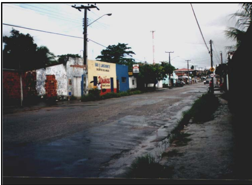
Figura 8: Avenida Pedro Dantas, principal avenida do bairro. Esgotos escorrem a céu aberto
