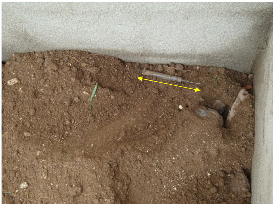
FIGURA 14 – Resíduos sépticos encontrados na área circunvizinha do posto de saúde da Comunidade Paus Branco. Jan/10
