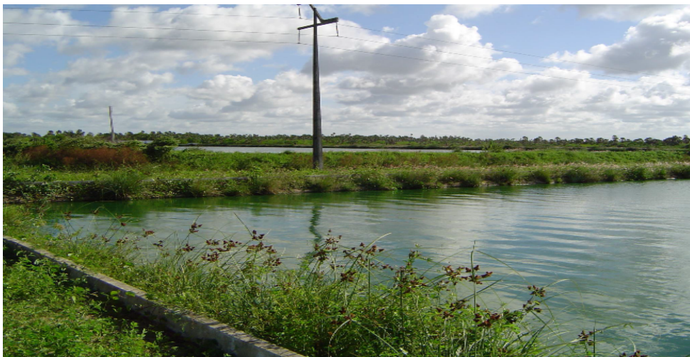
FIGURA 4.2 - Vista das lagoas de estabilização, Aquiraz, CE, 2005.
