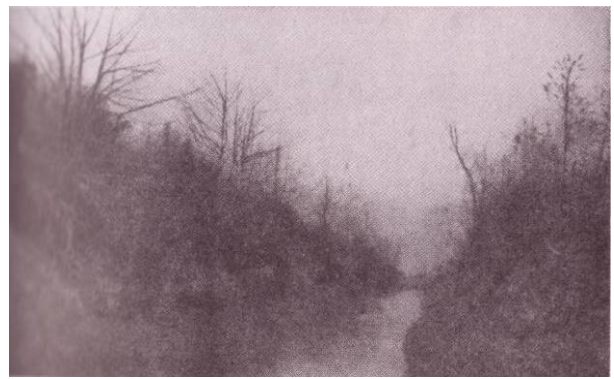
(B) Canal com lateral e fundo irregulares, margens cobertas com pequenos arbustos. Coeficiente de Rugosidade de Manning n = 0,045 (Fonte: Chow,1959).
