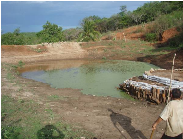
(c) Barragem de acumulação de água
