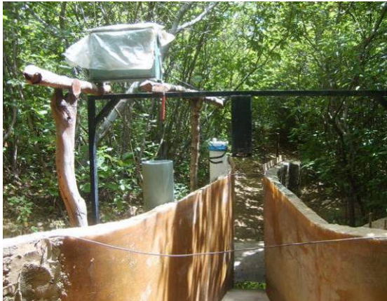
(d) Calha Parshall
