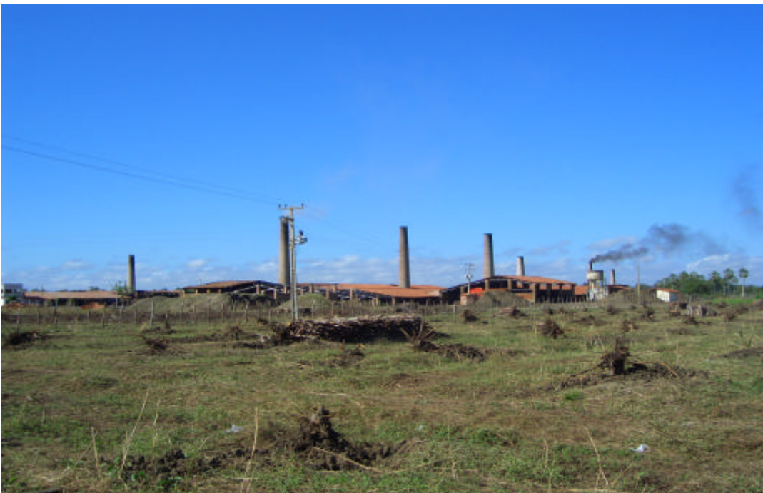
Foto 28. Área em fase de desmatamento, com o aproveitamento da lenha bastante fina, tudo indicando que posteriormente serão extraídos os materiais argilosos, sendo os mesmos talvez destinados às indústrias cerâmicas, vistas ao fundo.
