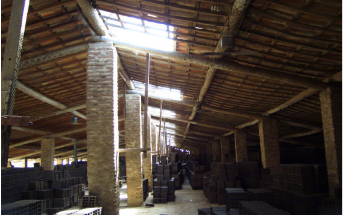
Foto 33. Galpão para secagem natural em indústria cerâmica da região do Vale do Jaguaribe que tem troncos de carnaubeiras como elemento estrutural na cobertura, bem como aberturas com controle para facilitar a circulação e a renovação do ar.
