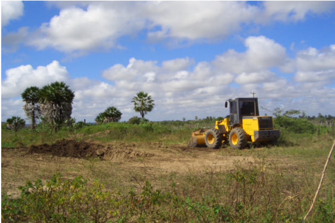
Foto 8. Pá carregadeira em fase inicial de extração irregular de argila, no município de Russas, fazendo inadequadamente o serviço de um trator de esteiras.
