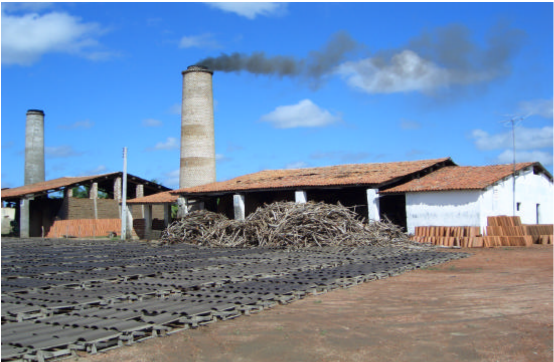
Foto 18. Telhas expostas ao sol para secagem final, antes de serem encaminhadas para a queima nos fornos.
