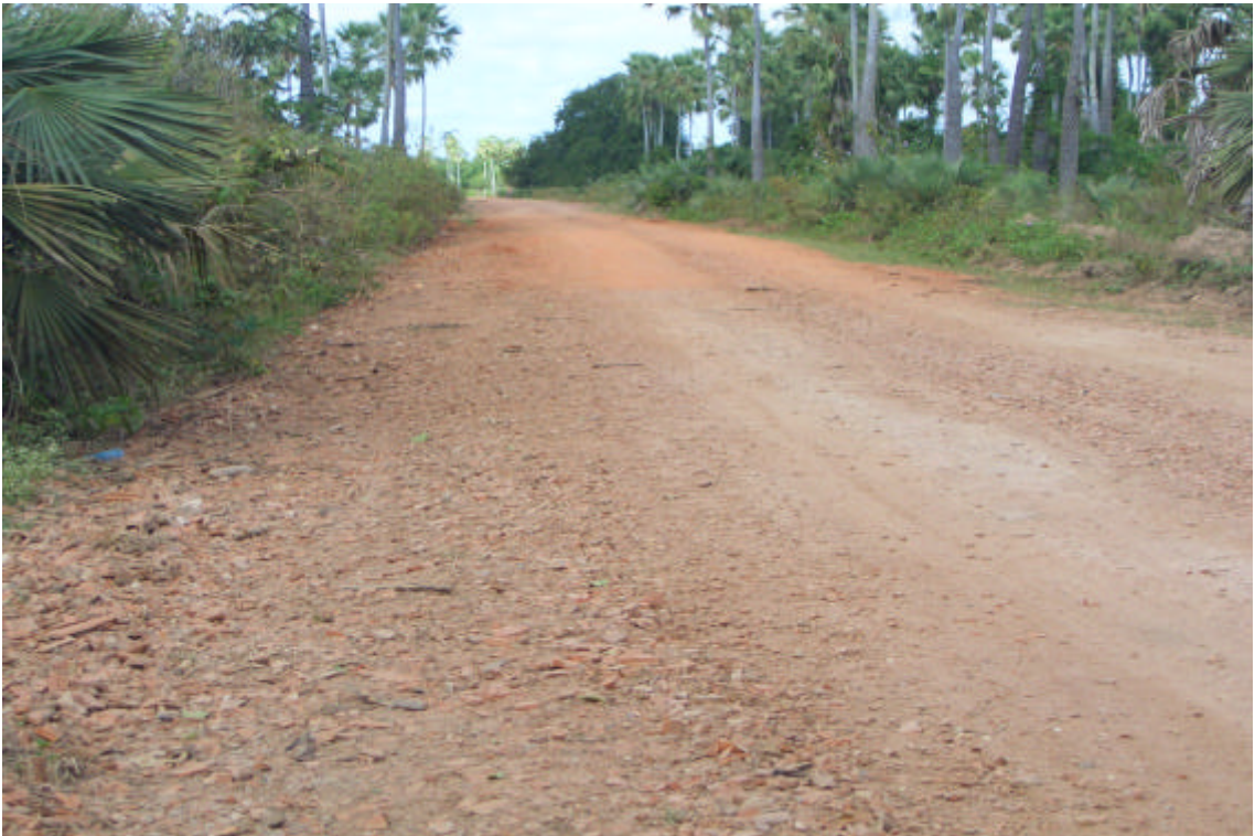
Foto 32. Estrada vicinal melhorada com o uso de rejeitos cerâmicos.
