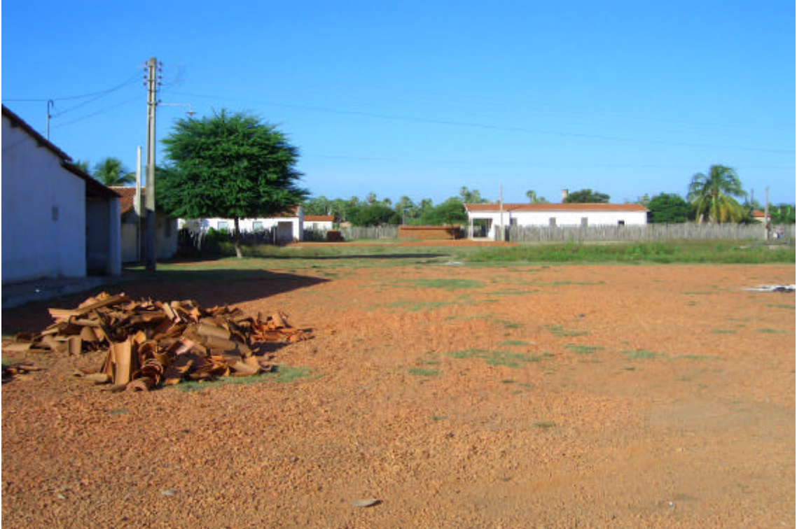
Foto 31. Pavimentação de pátio usando-se rejeitos cerâmicos.
