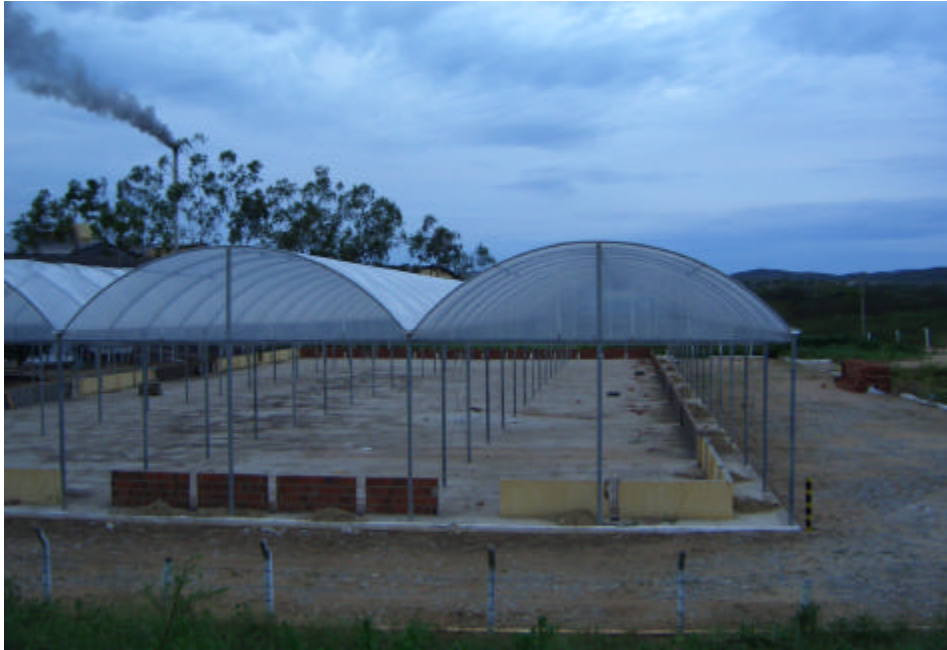
Foto 39. Galpão utilizado na secagem de castanhas de caju, cuja concepção poderia ser empregada para estocagem e secagem de lenha e peças cerâmicas, durante o período das chuvas.
