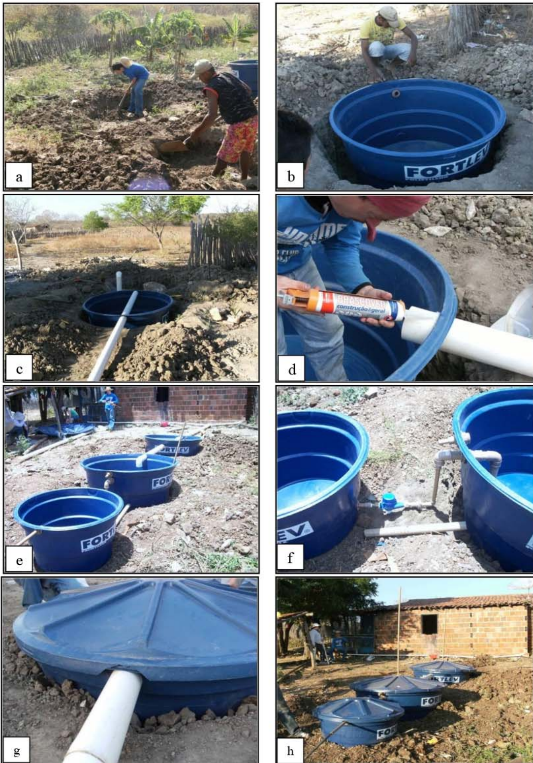
Figura 8 - Etapas de montagem da fossa modelo EMBRAPA, com hidrômetro acoplado (f) para medição do efluente. (Set. 2011).
