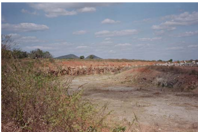
Foto 14: Sangradouro da barragem do Açude Pesqueiro.
