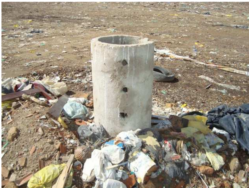
Figura 3.5 – Dreno para coleta de biogás
