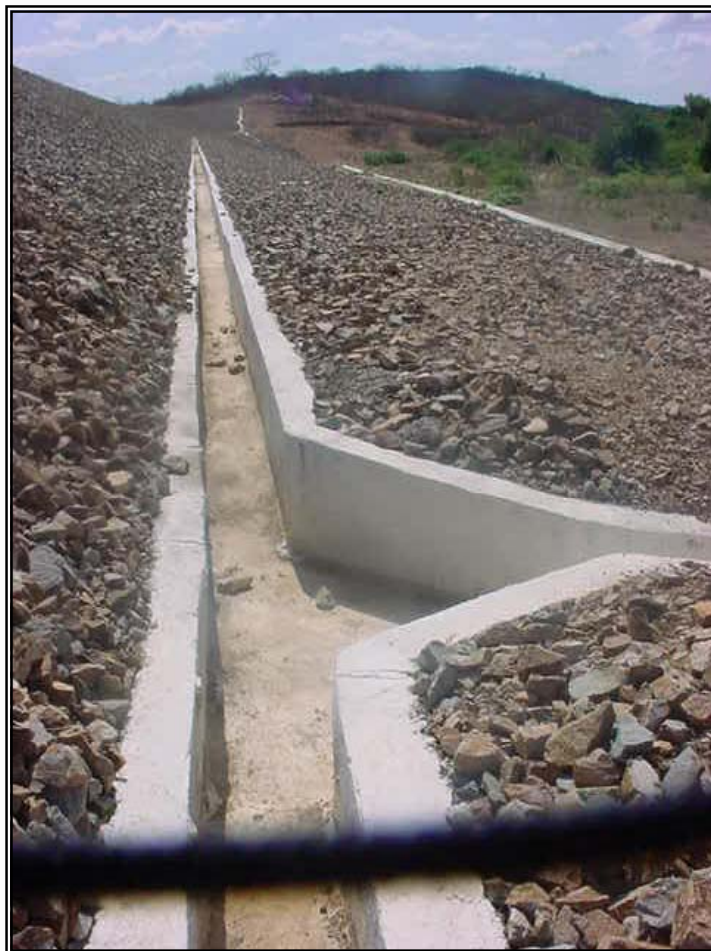
FIGURA 5.6 - Foto com Exemplo de Anomalia de Magnitude I (Insignificante)
