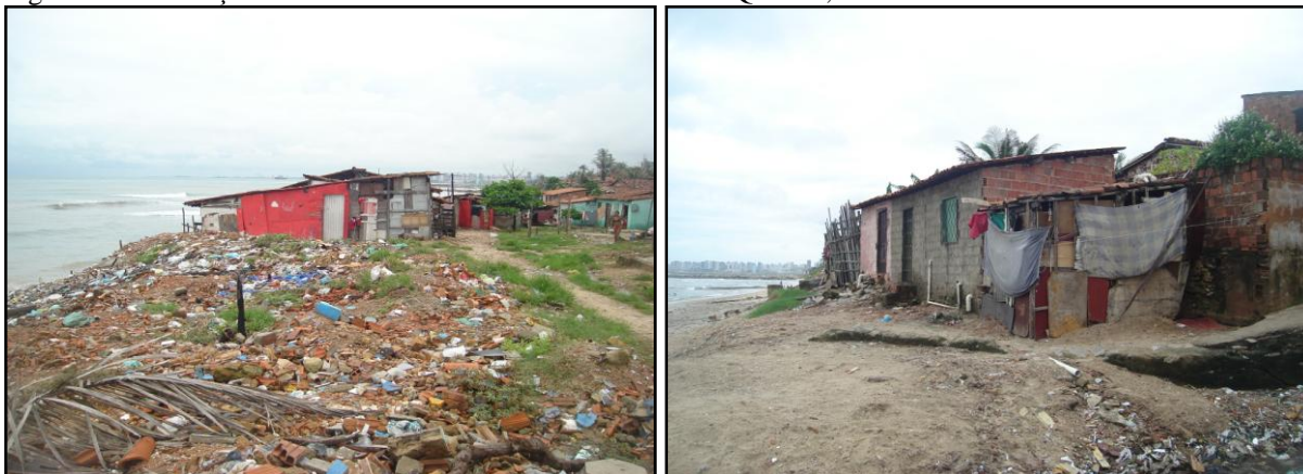
Figura 11 - Habitações em “área de risco” no bairro Pirambu - Queiroz, 2009.
