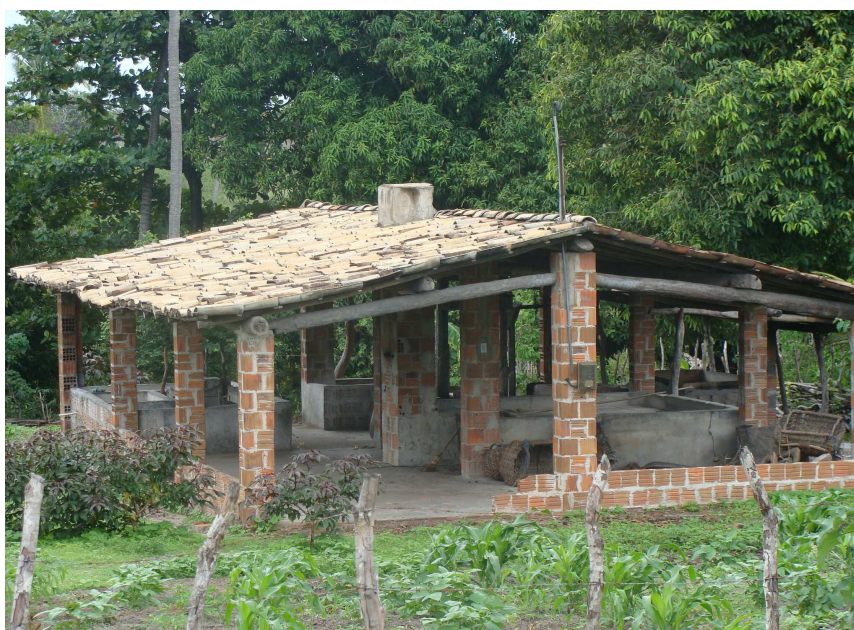
Figura 20: Casa de farinha localizada na comunidade Tremembé de São José. Estrutura em alvenaria, com tanques no interior e exterior, para o processamento da mandioca. Há também utensílios de cipó e madeira para o transporte da mandioca e da lenha, fev/2009.
