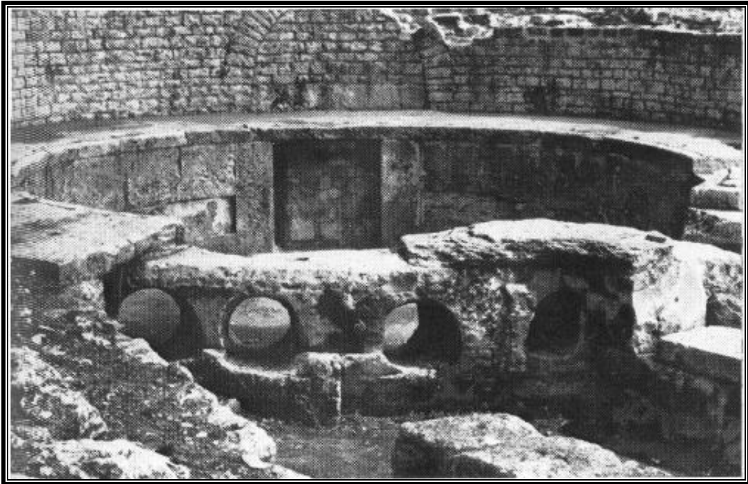
Figura 11 – Sistema de medição de vazão de água construído no Império Romano na Cidade de Nîmes (França), aproximadamente há 2000 anos atrás. Fonte: Landels (1979).
