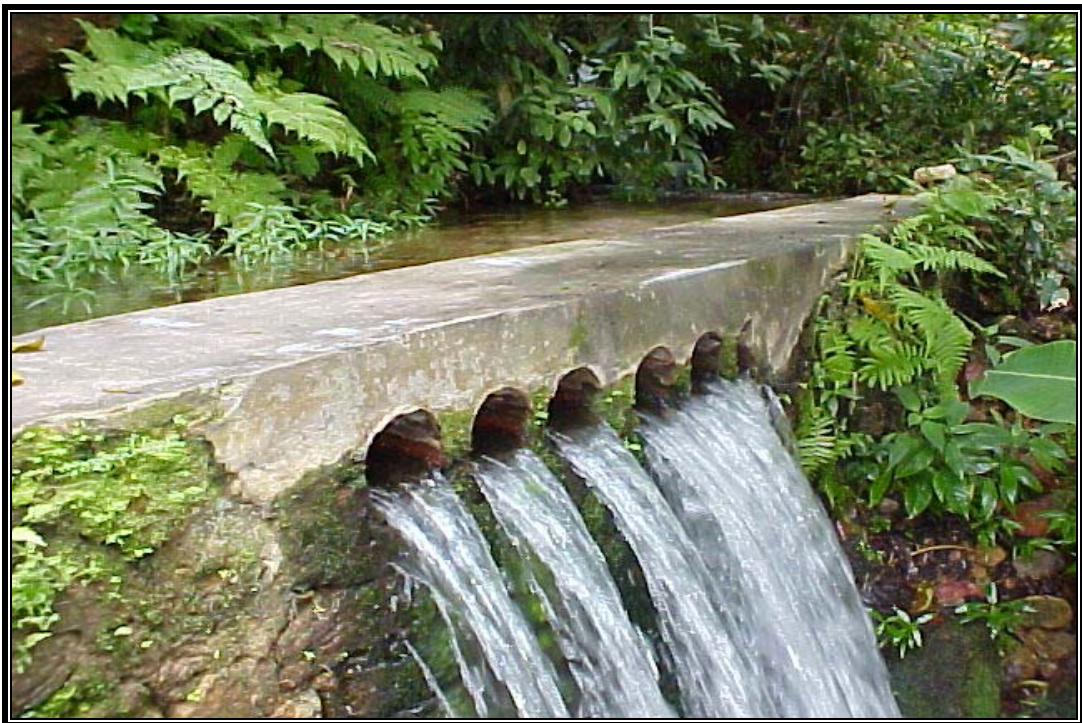
Figura 10 – Foto das telhas d’água (instrumento para medição de vazão) utilizadas na cidade do Crato (Cariri) a partir da partilha das águas da Fonte Batateira em 1855. Atualmente ainda em operação. Fonte: Elaboração própria (2004).
