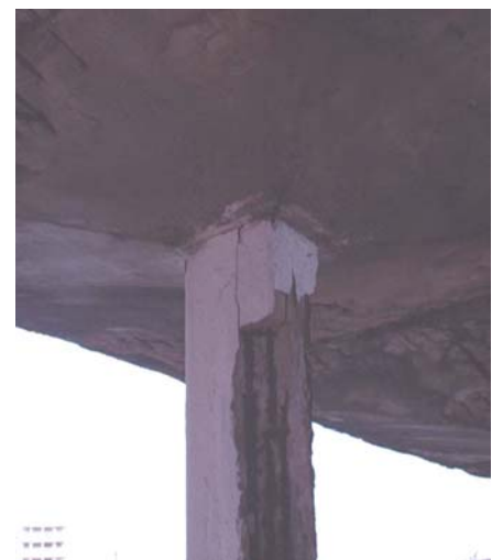
Figura 40/41- FONTE: DO AUTOR-29/01/05-PILAR E MARQUISE SOFREDO GRAVE PROCESSO DE OXIDAÇÃO
