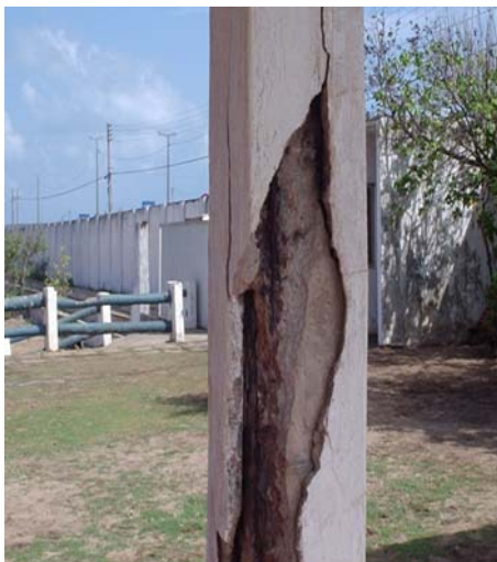
Figura 40/41- FONTE: DO AUTOR-29/01/05-PILAR E MARQUISE SOFREDO GRAVE PROCESSO DE OXIDAÇÃO
