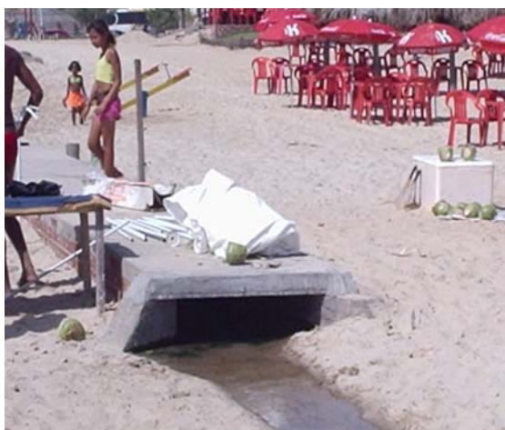
Figuras 32/33- FONTE: DO AUTOR 29/01/05. MOSTRANDO POLUIÇÃO RECENTE PROVENIENTE DOS EDIFÍCIOS MULTIFAMILIARES E BARRACAS DESAGUANDO NO MAR, ATRAVÉS DE GALERIAS DE ÁGUAS PLUVIAIS.
