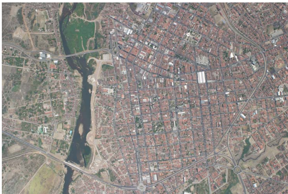
Foto 43: Aerofoto 2003 – Cidade de Sobral -obras da margem esquerda do rio Acaraú
