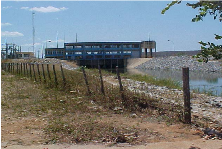
FIGURA 04 - Canal de Captação
