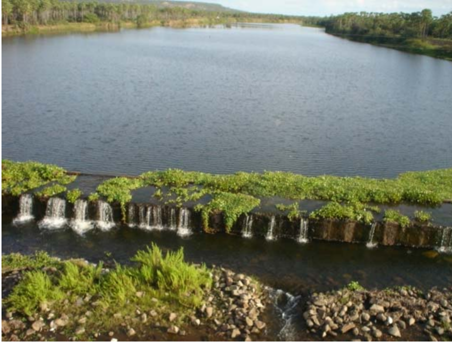
FIGURA 03 - Barragem das Pedrinhas
