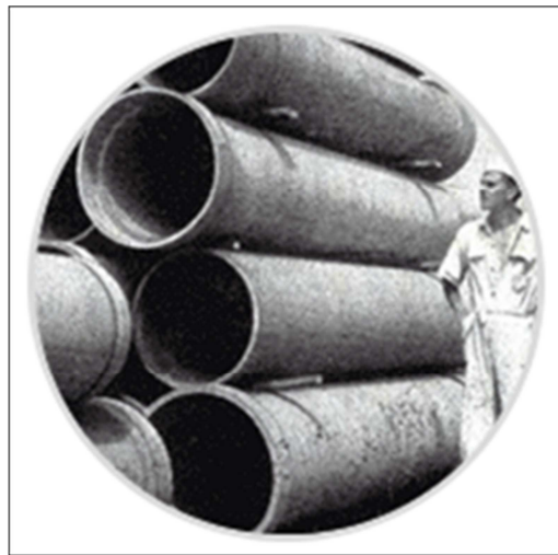
Figura 3 – Tubos de fibrocimento
