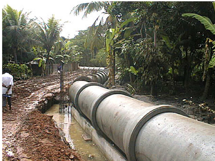
Figura 6 – Tubos de concreto
