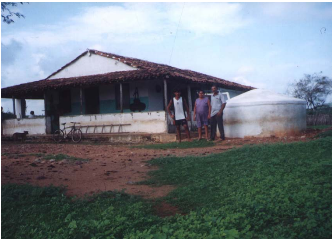
FOTO 1: Cisterna capta água da chuva em Livramento, município de Irauçuba.
