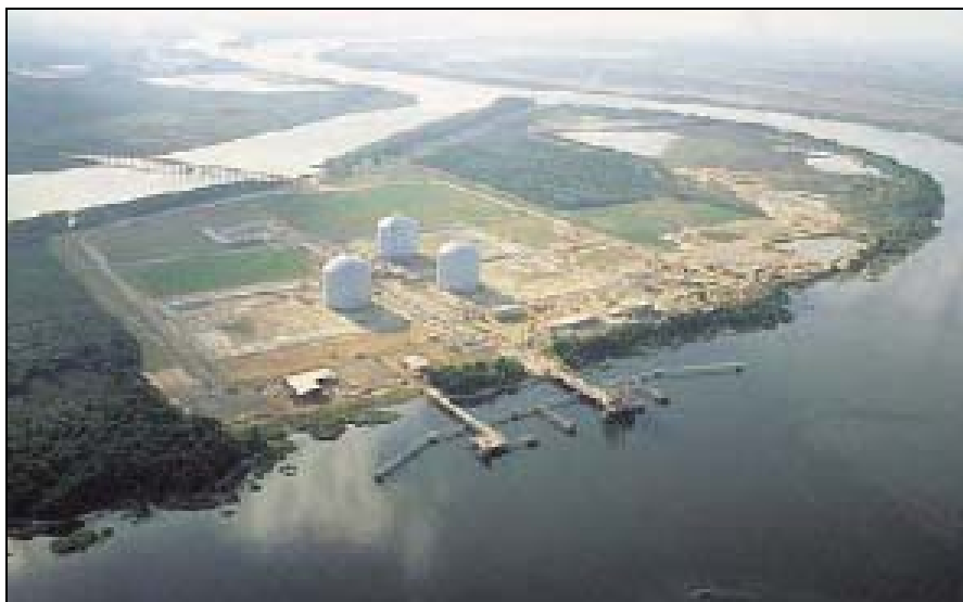
Figura 3.1 – Terminal de Regaseificação, Elba Island , Georgia - EUA
