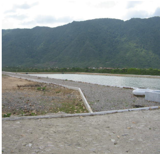
Figura 8 - Visão das lagoas de maturação I e II da ETE de Pacatuba-CE – 02/07/2008. Fonte: CAGECE (2008).
