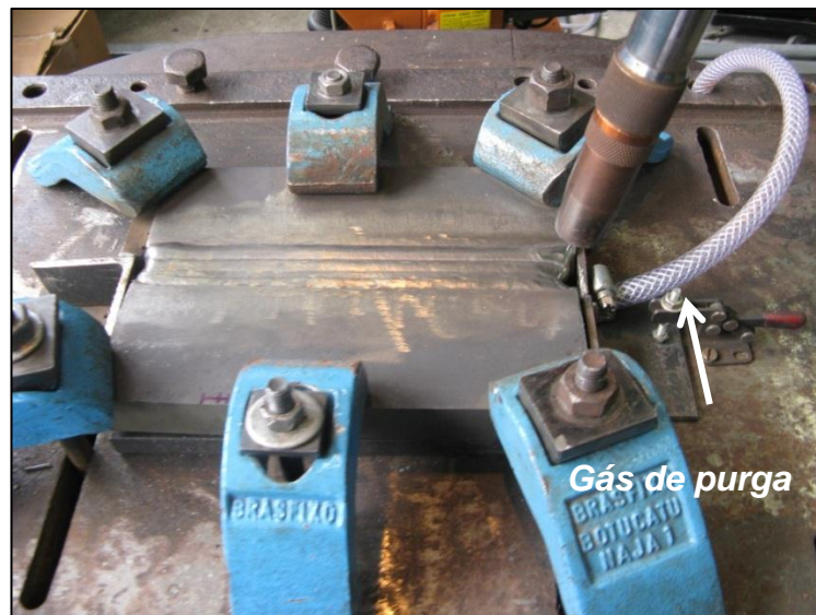
Figura 22. Fixação da junta de soldagem na bancada e a indicação da mangueira de alimentação de gás de purga pelo lado inferior da junta.
