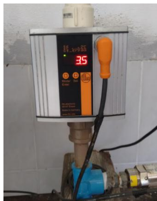
Figura 4. 15 - (a) Sensor de vazão na entrada,
