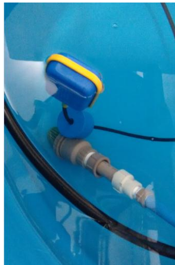
Figura 4. 22 - Chave-bóia unipolar
