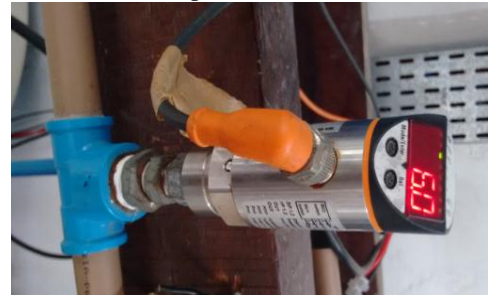
Fig. 4.16 (b) Sensor de pressão na saída do concentrado
