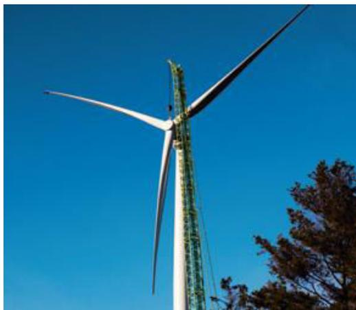
Figura 2 - Conceito padrão - HAWT tripá em montagem. Fonte: Siemens.
