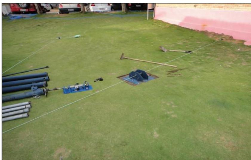
Figura 59 - Locação e montagem de ancoragens e base da torre do sistema de medição.
