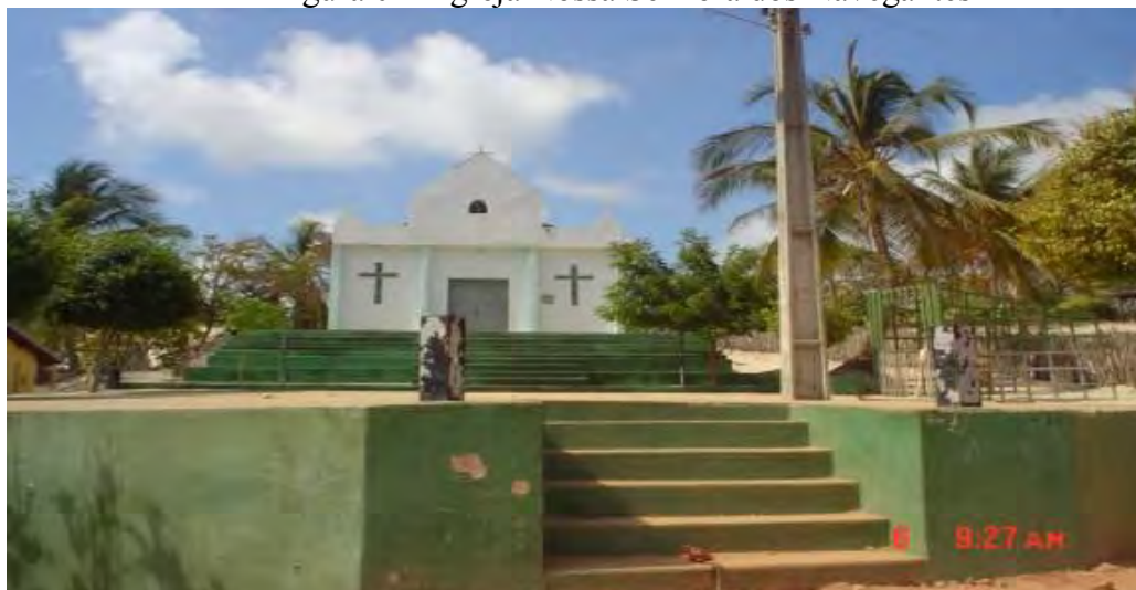
Figura 04 - Igreja Nossa Senhora dos Navegantes
