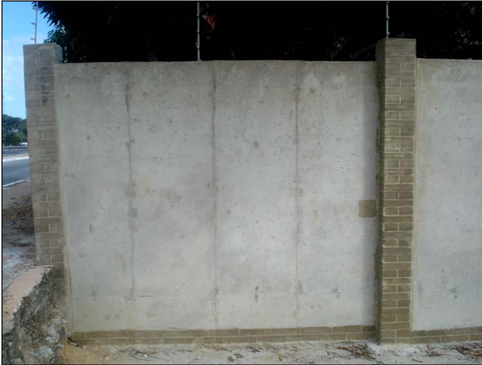
Figura 7A- Parede Externa da Usifort construída com placas de concreto e tijolos reciclados
