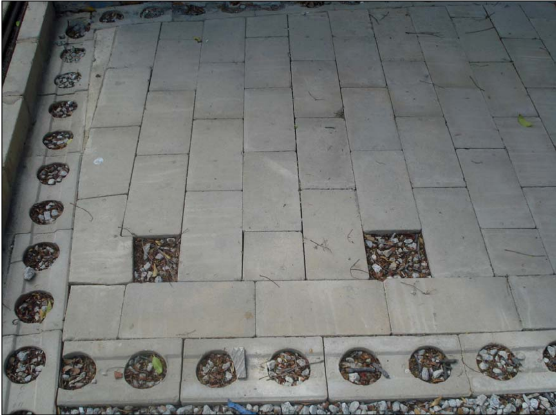
Figura 3A- Calçada feita com tijolo reciclado
