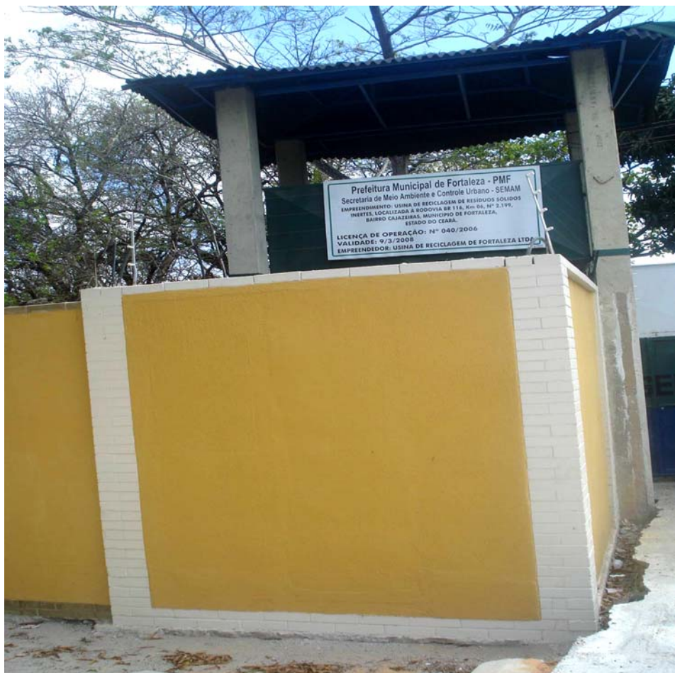
Figura 8A- Parede externa da USIFORT pintada
