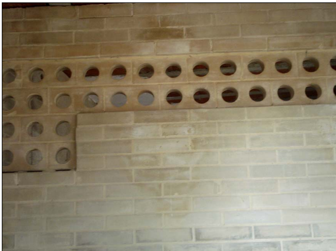
Figura 5A- Parede construída com tijolos ecológicos
