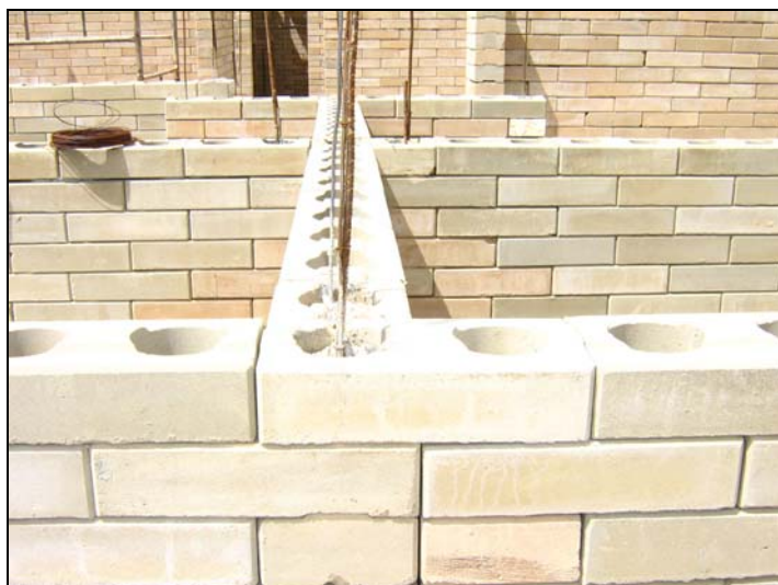
Figura 41- Aplicação do tijolo ecológico I Fonte: USIFORT
