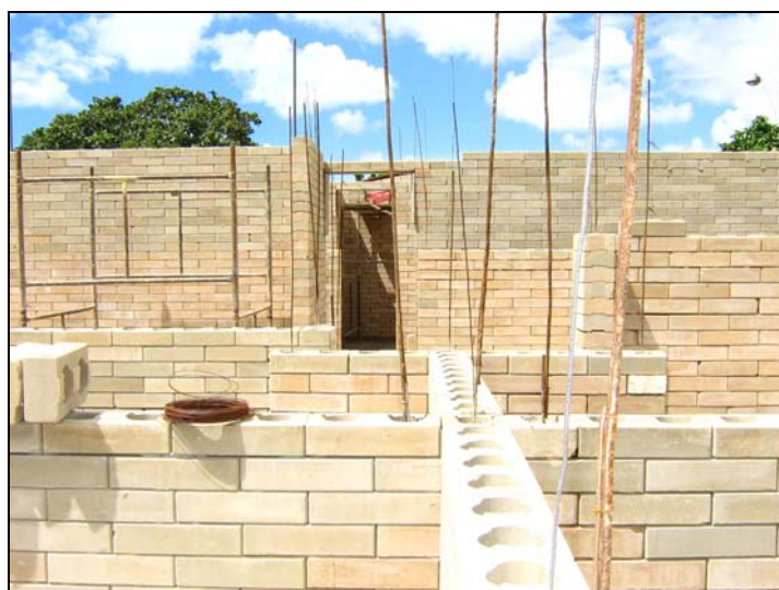
Figura 42- Aplicação do tijolo ecológico II Fonte: USIFORT
