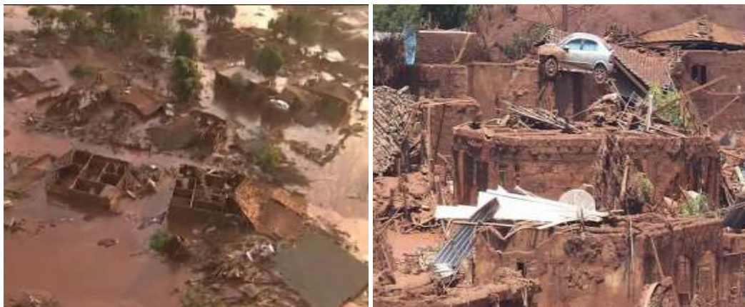
Bento Rodrigues após o rompimento da barragem de fundão
