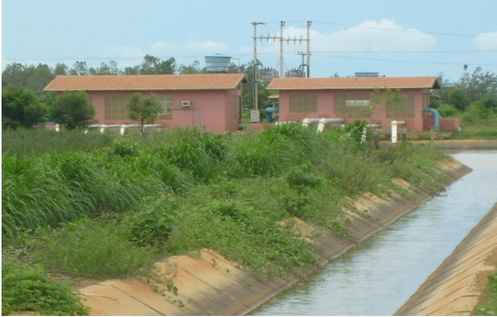
Foto 1 - Casa de bombeamento da água proveniente do rio Jaguaribe
