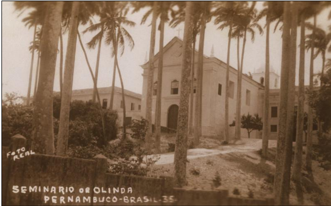
FIGURA 1 – Fotografia da fachada do Seminário de Olinda
