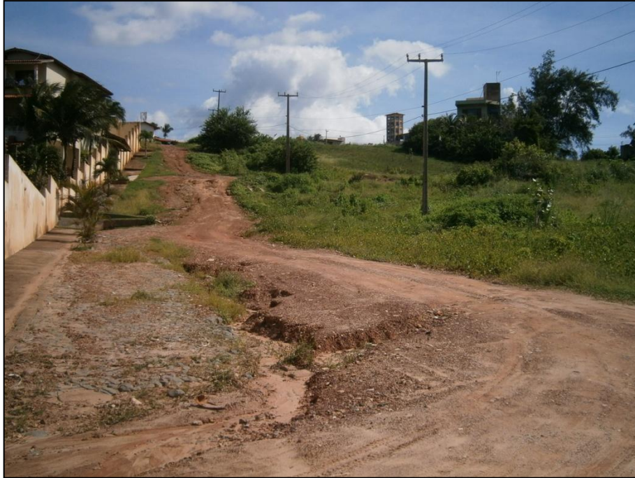
Foto 05 - Rua Arabaiana no Porto das Dunas, Aquiraz - CE, sem pavimentação apresentando processo erosivo. Coord.: 9573820/567656 (Janeiro/2014)
