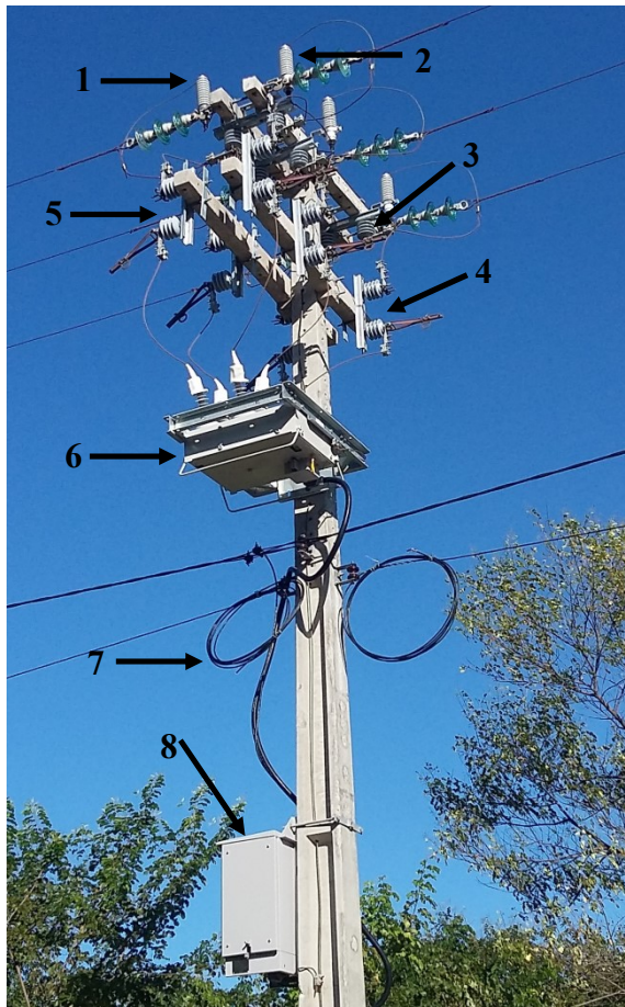
Figura 2.16 - Religador da rede de distribuição em MT do Pici
