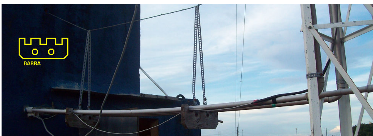
Figura 3.3 Suspensão dos tubos e cabos
