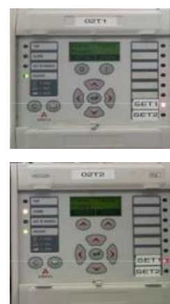
Figura 6.3 - Tela do CLP500 para Caso de Transformadores em Paralelo - Condição Normal.
