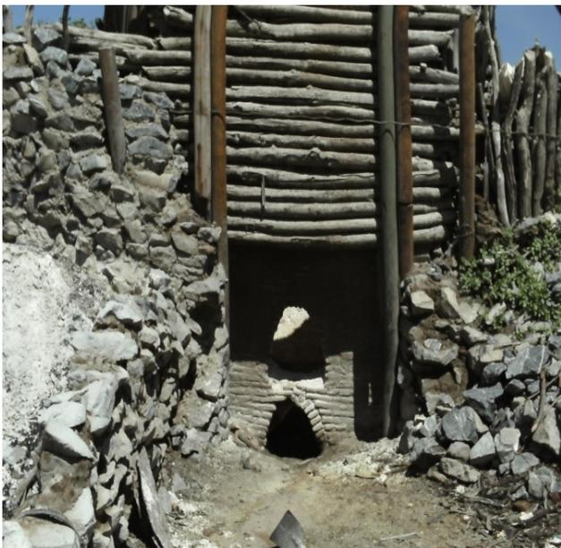
Figura 3 - Forno do tipo caieira utilizado na calcinação de calcário. Local fazenda Pau d'arco, comunidade de Pedra de Fogo (município de Sobral).
