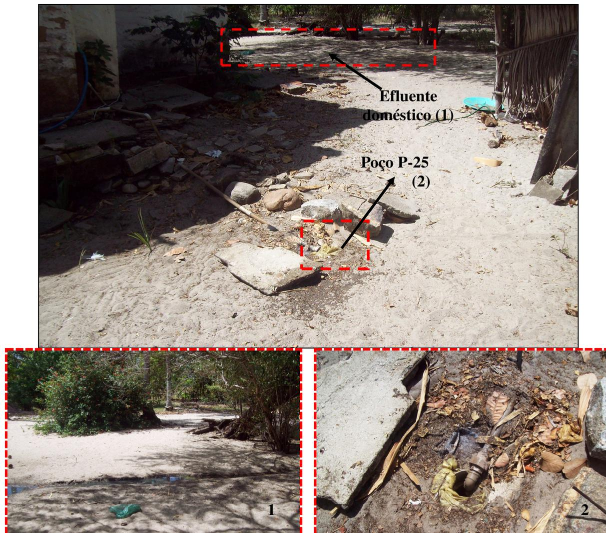
**Figura 27.** Vista do poço tubular P-25 (foto superior). No detalhe a direita, efluente doméstico observado próximo ao poço. No detalhe a esquerda, vista superior do poço. Coord. UTM: 514358N/9606940E (Dezembro/2013).
