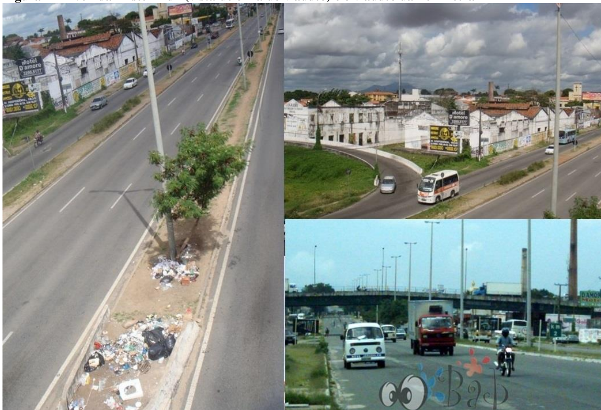
Figura 2 – Avenida Mister Hull (vista de cima do viaduto) e o viaduto da Perimetral
