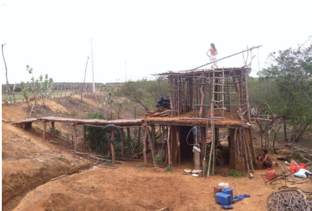
Figura 15 - Casa de argila em construção no assentamento.
