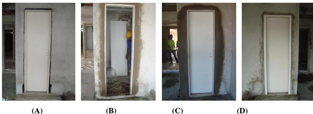
**Figura 5.21** – A: Fixação permanente. B: Retirada da folha de porta. C: Acabamento. D: Fixação dos alisares
