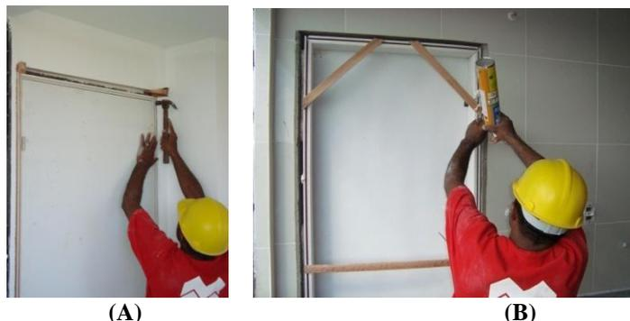
**Figura 5.23** – A: Fixação provisória. B: Fixação permanente.
