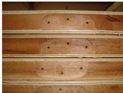
**Figura 5.11** – Detalhe do rasgo da dobradiça
