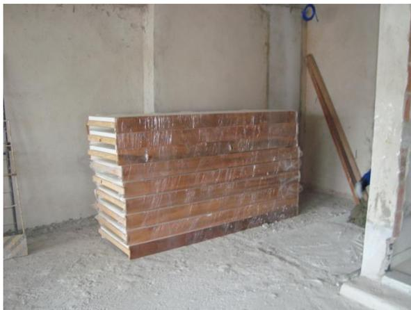
**Figura 5.20** – Armazenamento das portas no pavimento
