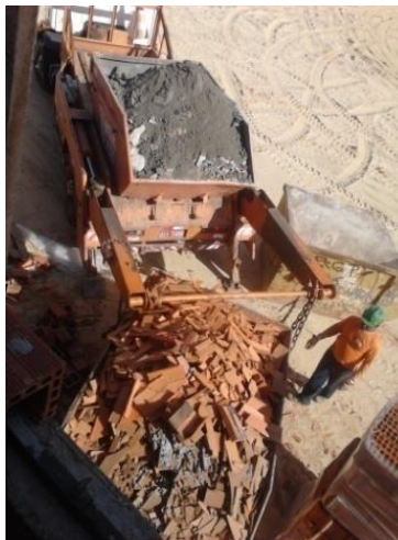
Figura 29 – Contêineres no caminhão tipo Munck
