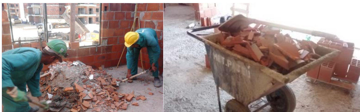
Figura 28 - Remoção do resíduo no pavimento
