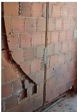
Figura 26 - Alvenaria com rasgo para receber a instalação
