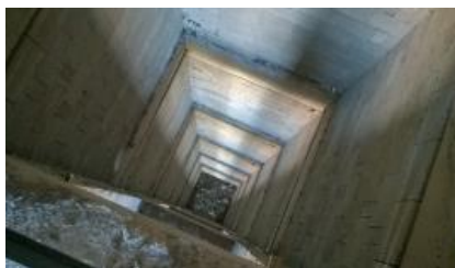
Figura 30 - Vista do fosso que irá receber o coletor
