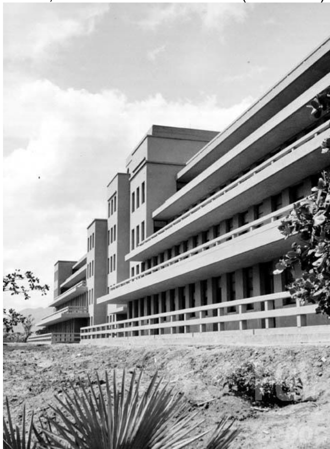
Figura 53 – Aspectos da fachada do Sanatório do Recife, entre out de 1939 e 1945 (Data certa).
