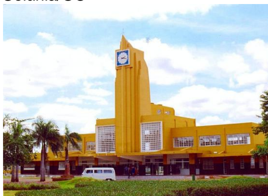
Figura 83 – Torre do relógio da antiga estação ferroviária de Goiânia/GO
