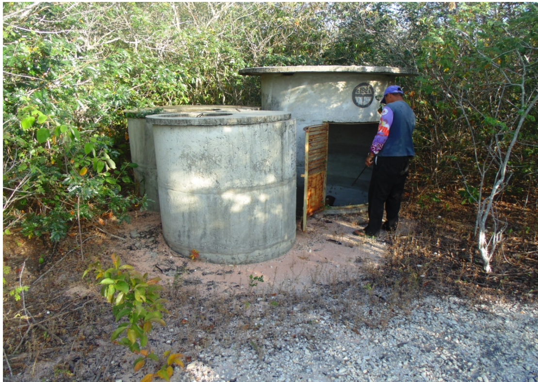
Figura 4: Caixas de concreto instaladas pelo DNOCS em um lugar dentro da Mata do Amargoso
