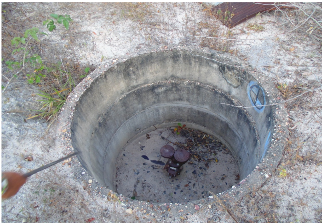
Figura 5: Estrutura de concreto instalada pelo DNOCS com suporte para bomba de água.
