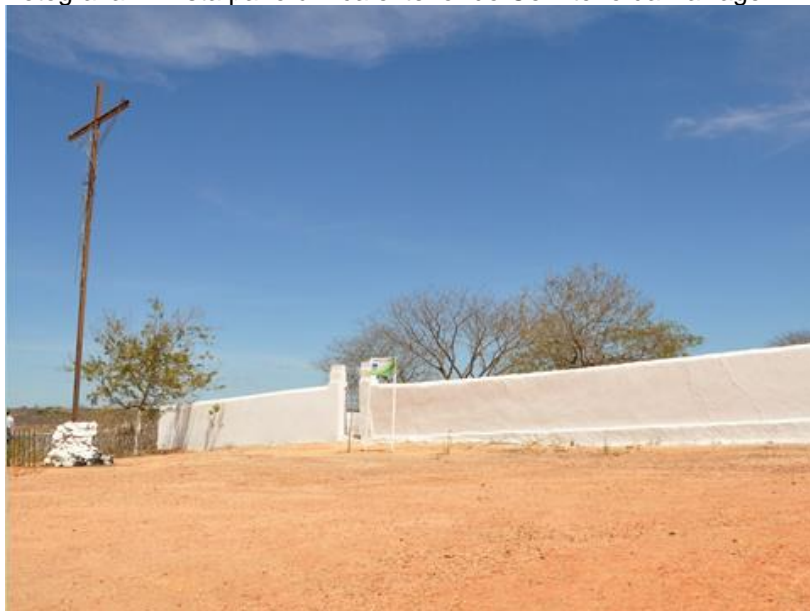
Fotografia 1: Vista panorâmica exterior do Cemitério da Barragem.
