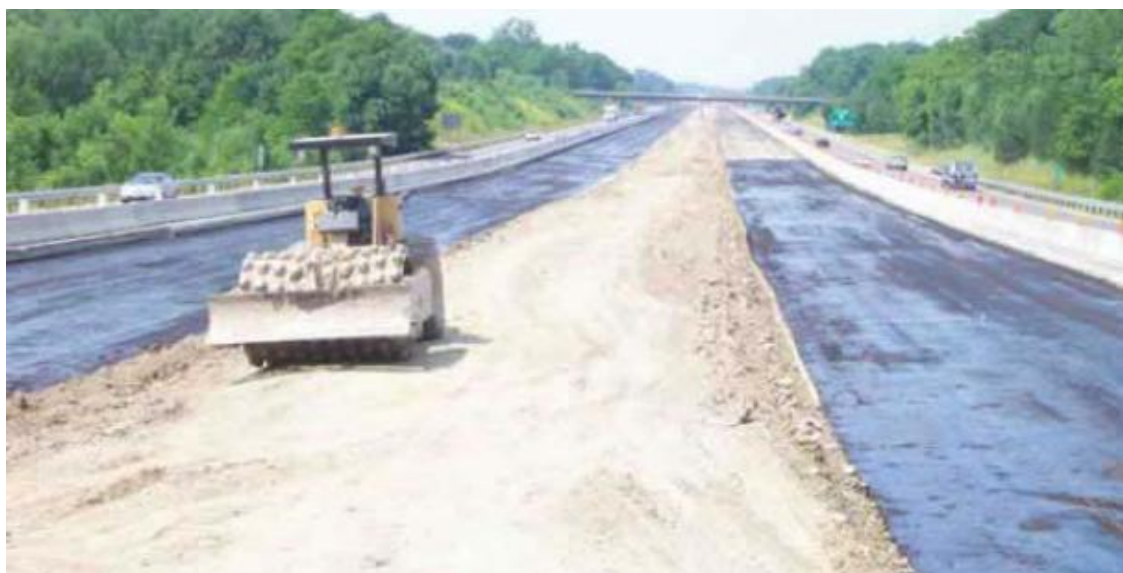
Figura 2.28: Cura por imprimação betuminosa (NLA, 2004)
