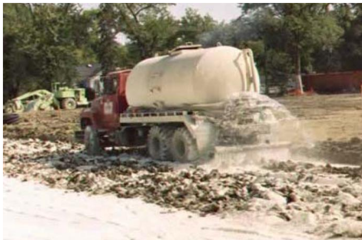
Figura 2.24: Adicionamento de água após a aplicação da cal em pó (NLA, 2004).
