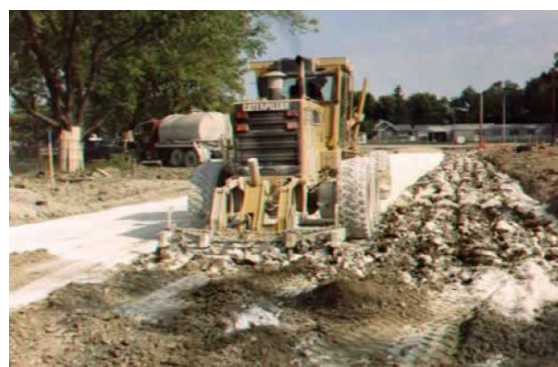
Figura 2.23: Escarificação e pulverização após a distribuição da cal em pó (NLA, 2004).
