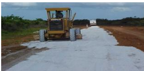
Figura 2.3: Trecho da rodovia do Melão em execução (LOYOLA e BARROSO, 2007).
