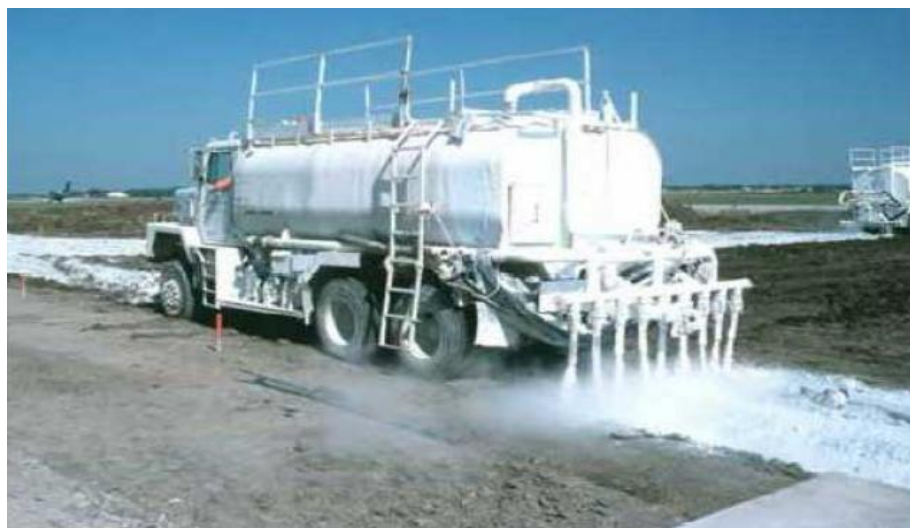
Figura 2.21: Exemplo de aplicação da pasta de cal com o espalhador pneumático (NLA, 2004).
