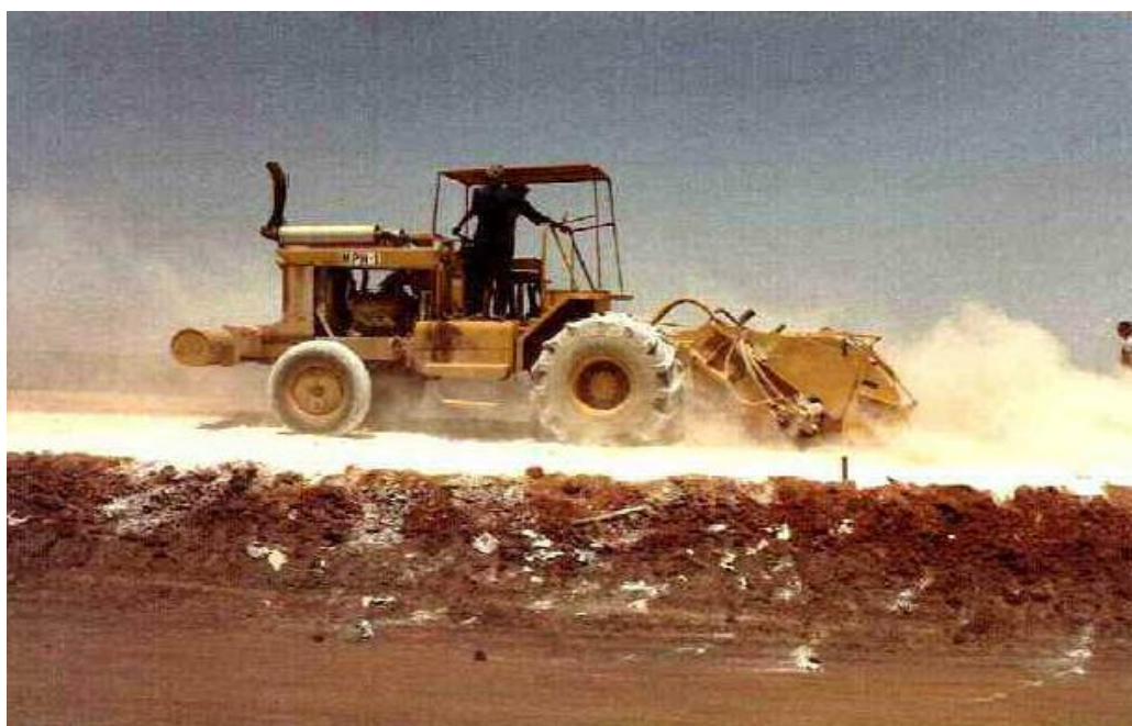
Figura 2.25: Mistura da cal ao solo simultaneamente a adição de água (IFG, 2005).
