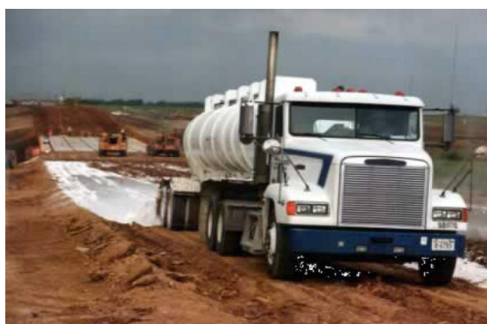
Figura 2.22: Enleiramento lateral do solo para contenção da cal antes do processo de mistura (NLA, 2004).
