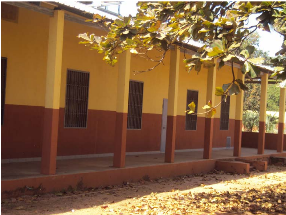
Varandas internas do Internato de Bor. Acesso a quadra de terra.
