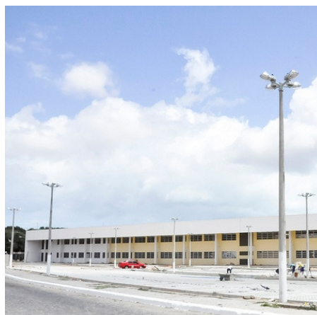
Foto 2: Prédio do ICA
