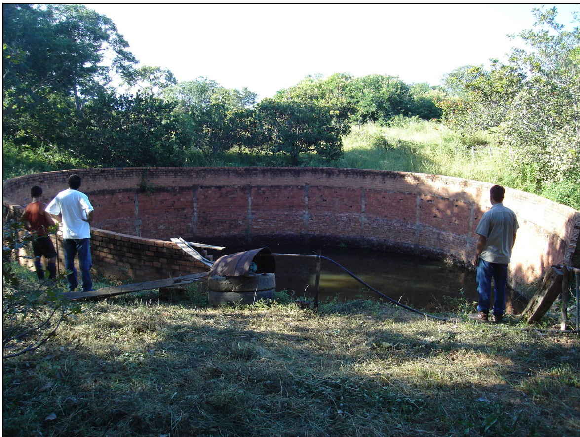
Foto 6.1 – Poço amazonas no município de Barbalha. 468760W / 9195274S. (03/05/2007).
