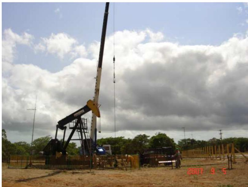
Figura 12 – Retirada de parte dos equipamentos do poço para injeção de vapor. Campo Fazenda Belém.
