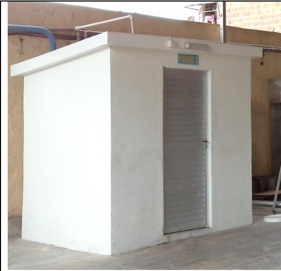
Figura 3: Casa do poço higienizada e identificada. Fonte: Costa, 2012
