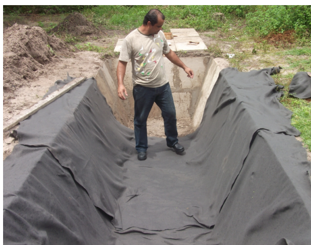
Figura 4.14: Instalação da manta geotextil.
