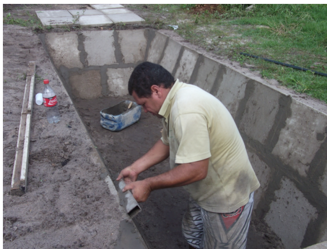
Figura 4.13: Trincheira modelada com as placas pré-moldadas de cimento
