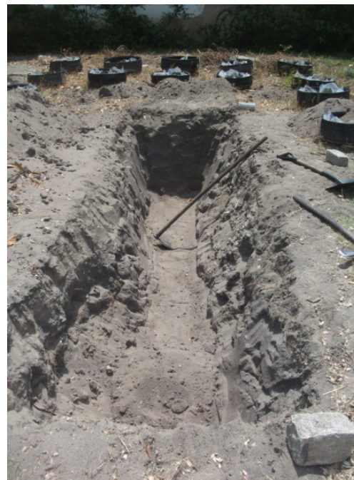
Figura 4.12: Trincheira para instalação do biodigestor
