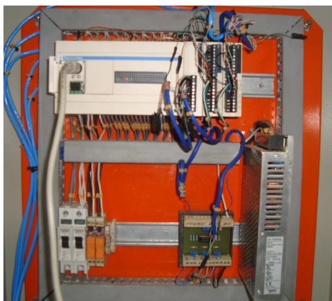
Figura 4.4: Controlador lógico programável e expansões.
