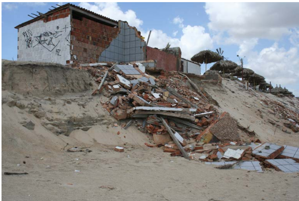
Figura 51 – Destruição de casa provocada pela erosão costeira na praia do Icaraí.
