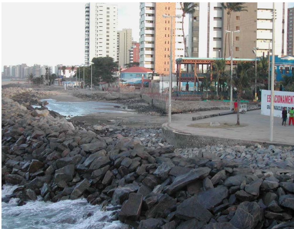
Figura 43 – Estruturas de proteção de costa ao longo de todo o calçadão visando conter a ação da dinâmica costeira sobre as estruturas e casas.
