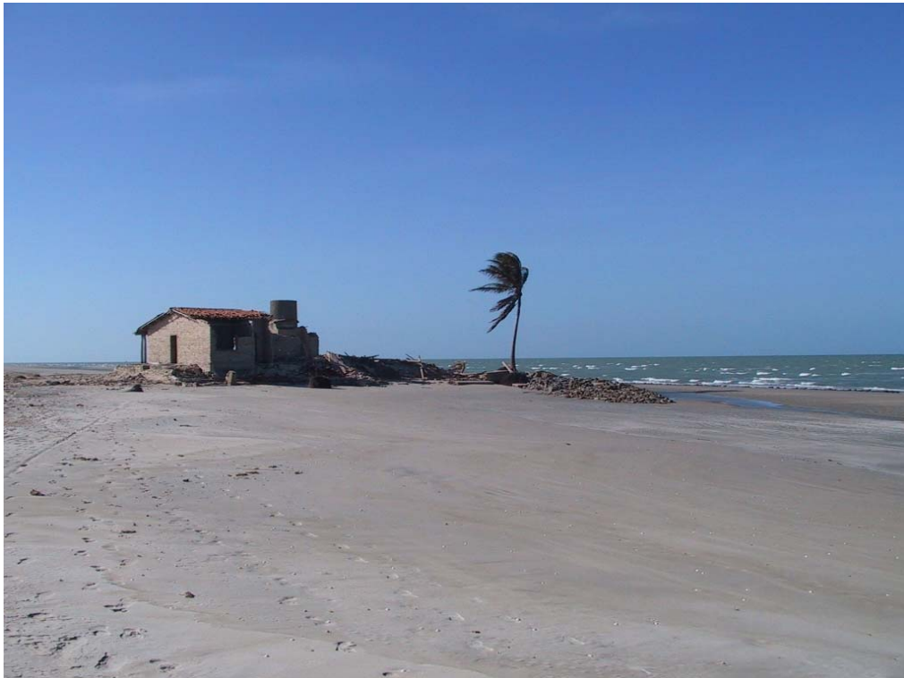
Figura 33 – Casa destruída pela ação da erosão costeira na região de Itarema.
