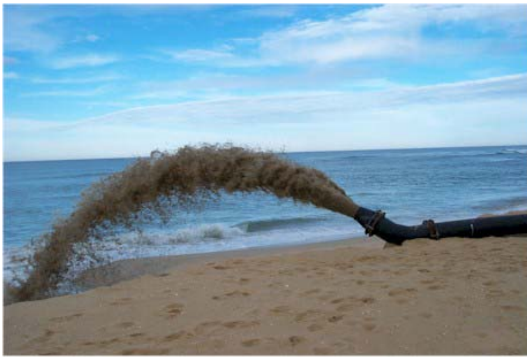
Figura 64 - Engorda artificial na praia de Bairnsdale, Austrália
