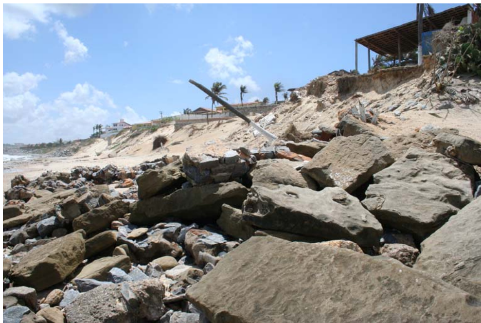
Figura 53 – Destruição de estruturas e modificação da paisagem em decorrência da erosão costeira.
