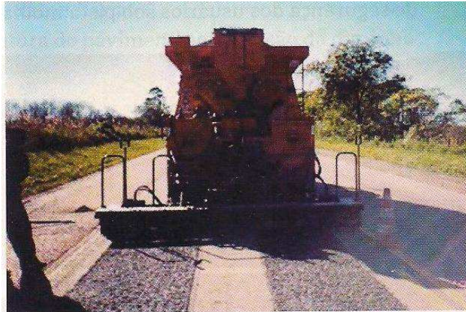
Figura 3 – Aplicação de MRAF para preenchimento de ATR
