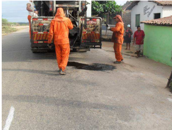
Figura 12 – Correções de pequenos defeitos superficiais
