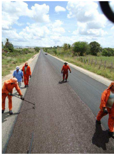
c) correção de irregularidades na camada
