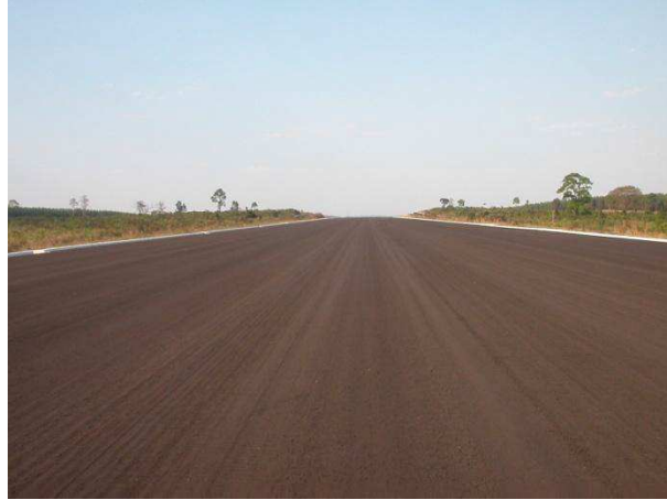
Figura 6 – Aplicação do MRAF em pistas de aeroportos
