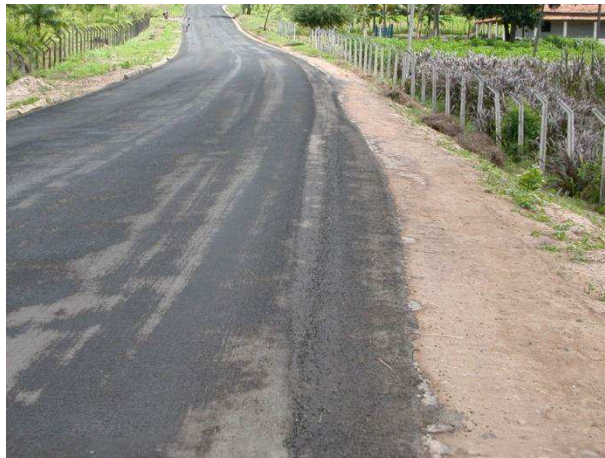
Figura 11 – Umedecimento do pavimento antes da aplicação do MRAF
