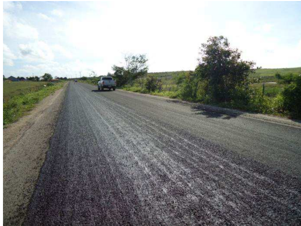
Figura 26 – Liberação do trecho ao tráfego
