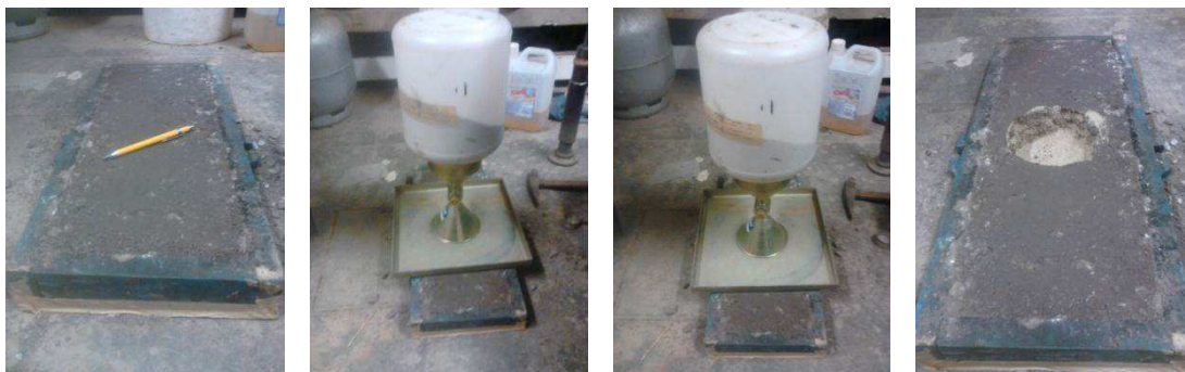
Figura 86 – Realização do ensaio de densidade in situ na base de solo-brita
