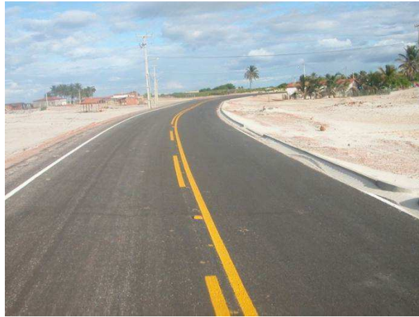
Figura 4 – Aplicação do MRAF sobre base imprimada no estado do Rio Grande do Norte
