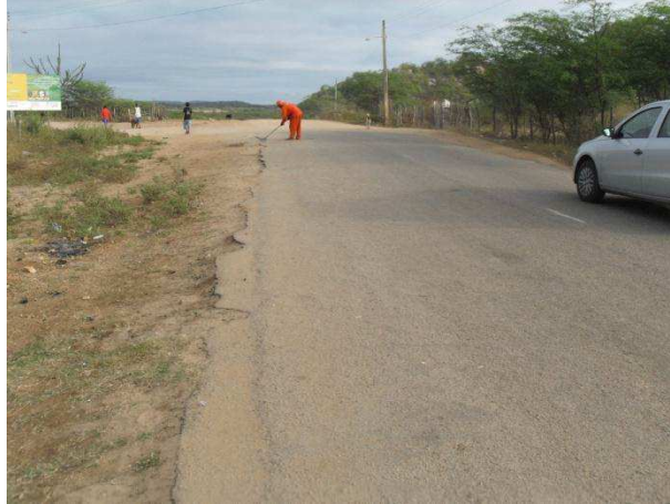
Figura 10 – Remoção manual de impurezas do pavimento
