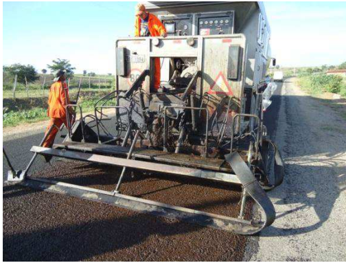
a) aplicação do revestimento
