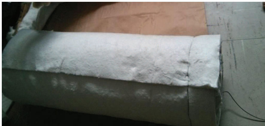
Figura 40 — Isolamento do tubo de quartzo
